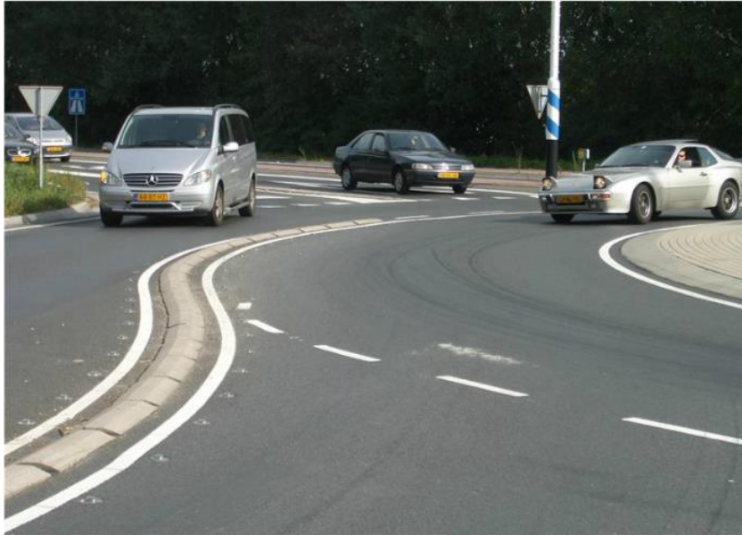
Slika 46. Niski rubnjaci unutar kružnog toka u Nizozemskoj
