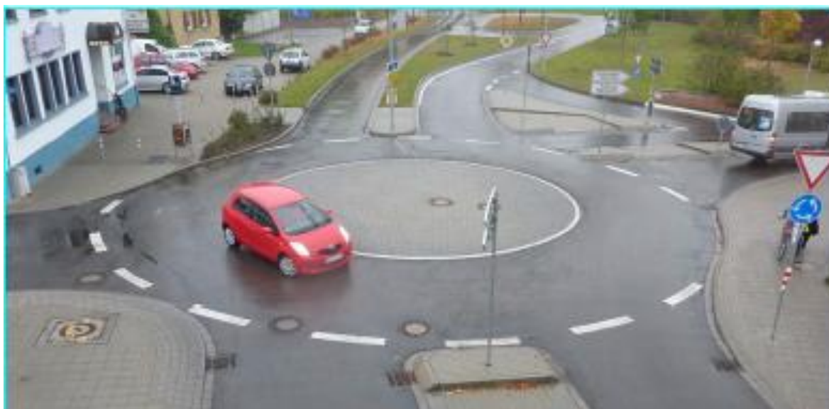
Slika 16. Mini kružni tok u Karlsruheu
