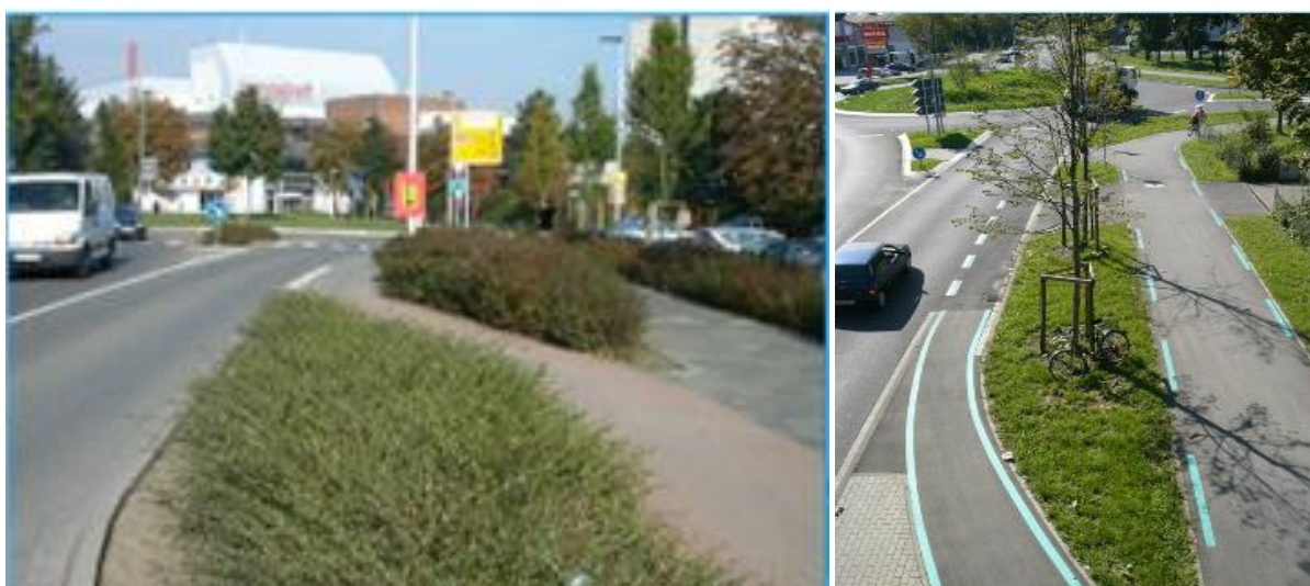
Slika 26. Usmjeravanje biciklističke staze na cestu
