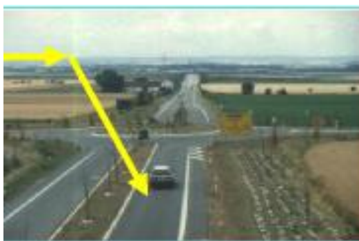
Slika 20. Okomiti prilaz jednotračnom kružnom toku
