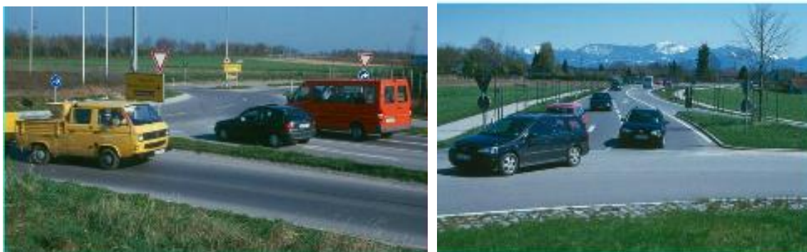
Slika 38. Primjer dvotračnih ulaza bez zebre
