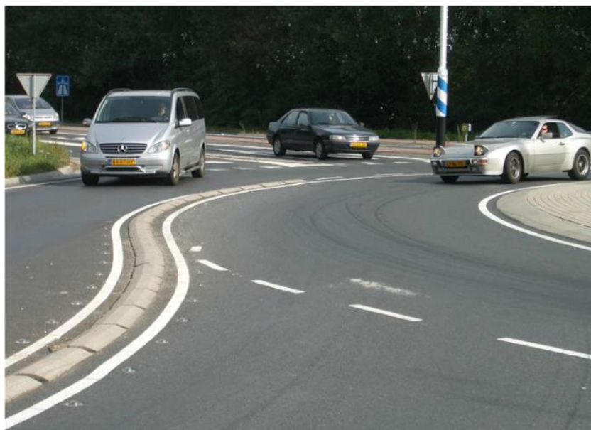
Slika 46. Niski rubnjaci unutar kružnog toka u Nizozemskoj
