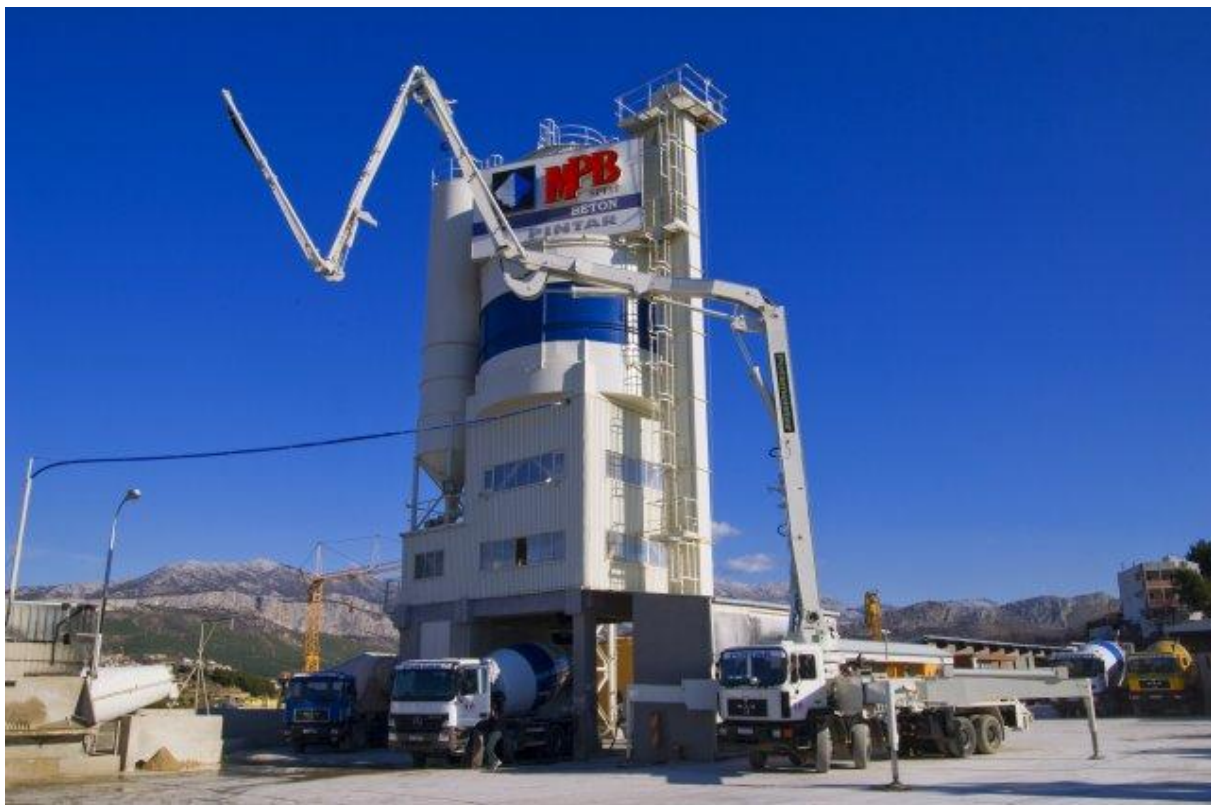
Tvornica betona Sirobuja (betonara Arbau BHS 2000 kapaciteta 120 m 3 /h)
