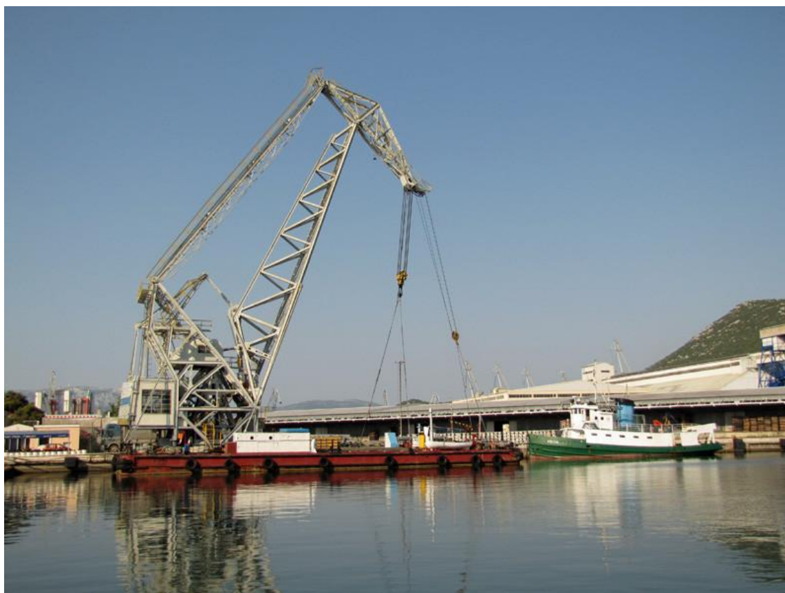
Plovna dizalica "Brina", nosivost 100 t
