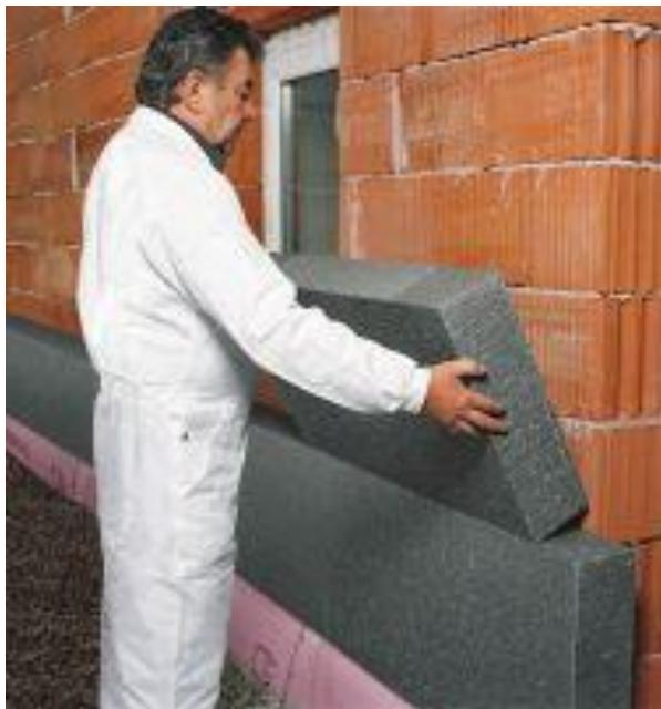
**Slika 2.5.** Ugradnja ekspandiranog polimernog materijala (polistiren). [10]
