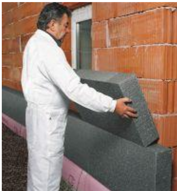
Slika 2.5. Ugradnja ekspaniranog polimernog materijala (polistiren). [10]
