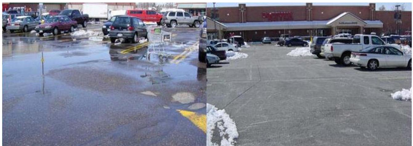
Slika 1.2 Odnos brzine sušenja između asfaltog kolnika i kolnika od poroznog betona [3]
