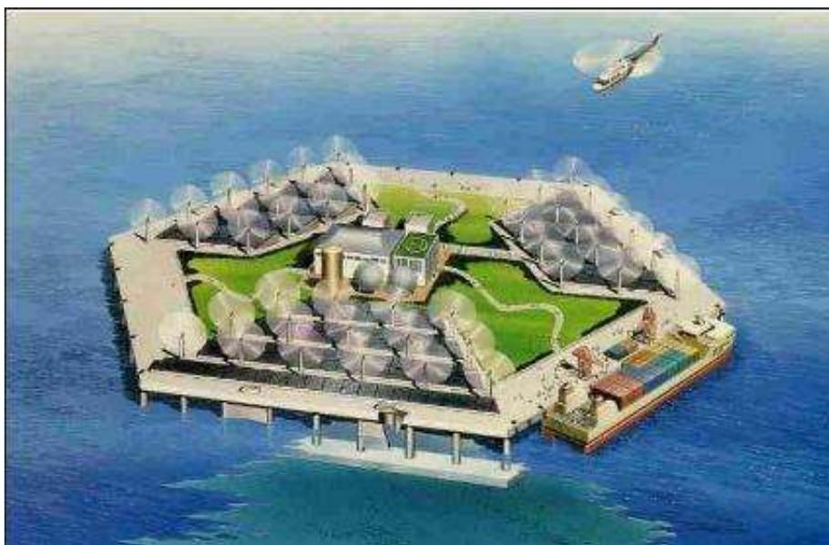
Slika 2.22 Primjer plutajuće ne zagađujuće elektrane koju predlaže Japanska udruga za projektiranje plutajućih konstrukcija [2]
