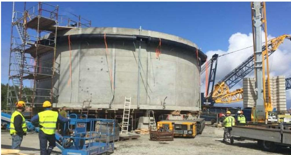
*Slika 5.6 Zatvoreni betonski plutajući kavez za uzgoj ribe [32]*
