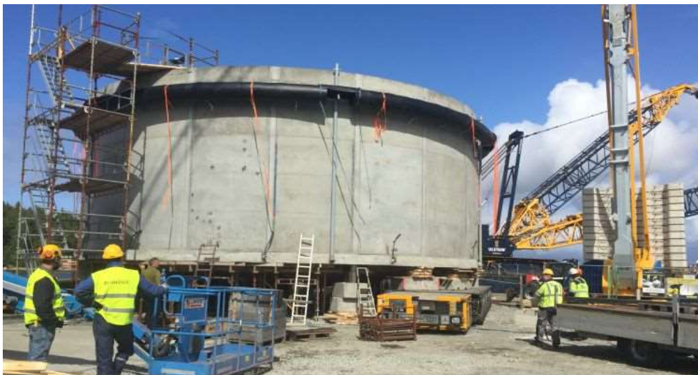
Slika 5.6 Zatvoreni betonski plutajući kavez za uzgoj ribe [32]
