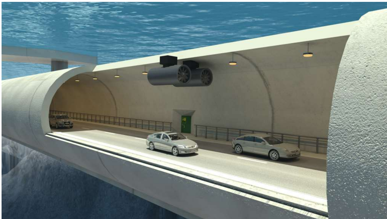
Slika 2.20 Primjer modela potopljenih plutajućih tunela [7]
