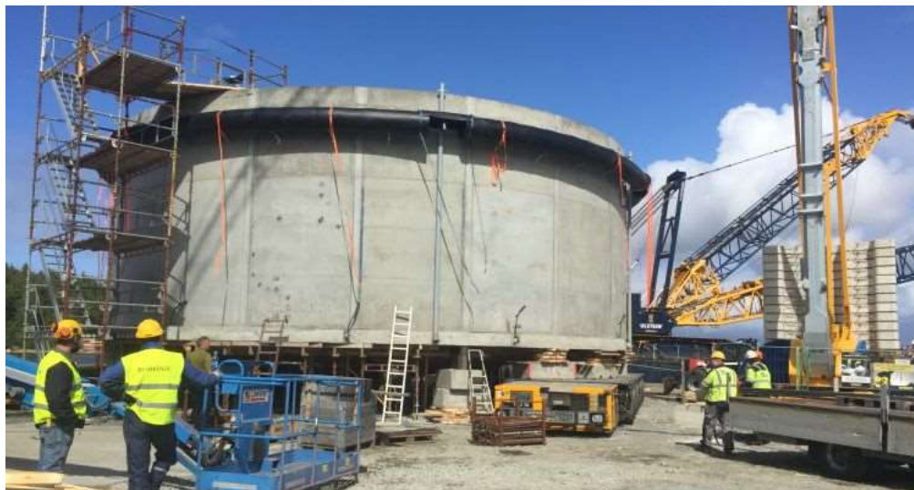
Slika 5.6 Zatvoreni betonski plutajući kavez za uzgoj ribe [32]
