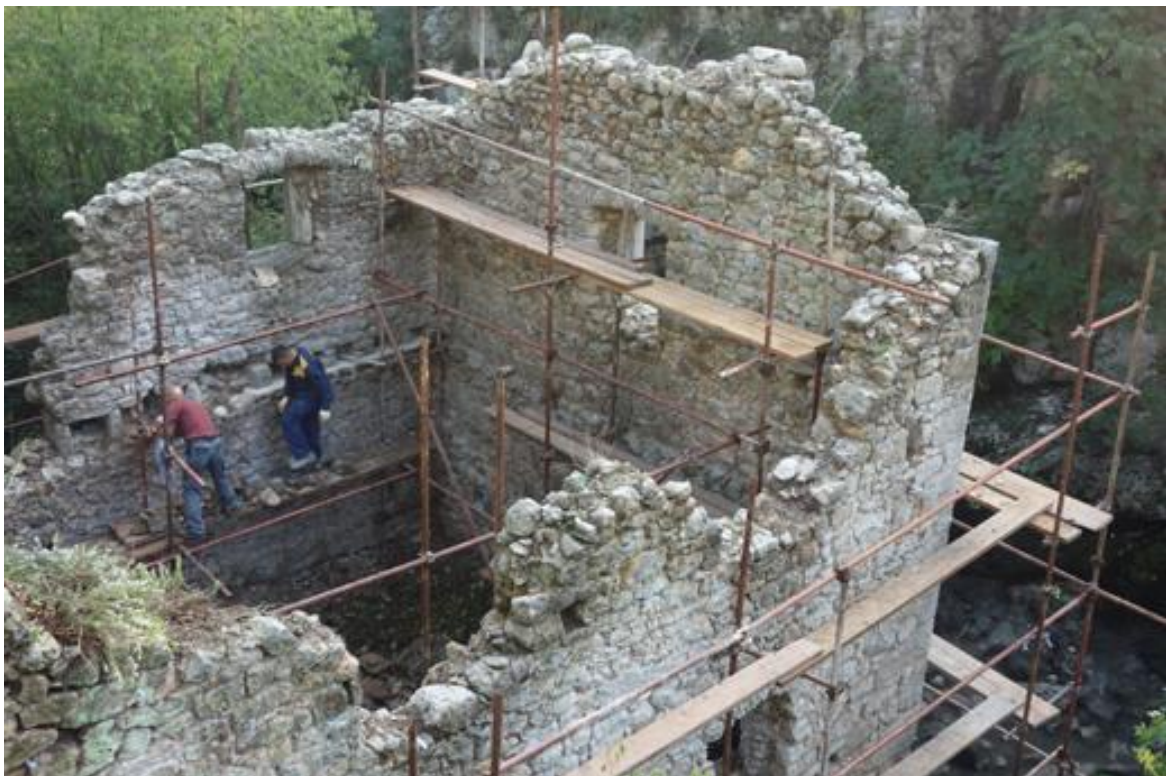
Slika 20. Obnova stare mlinice
