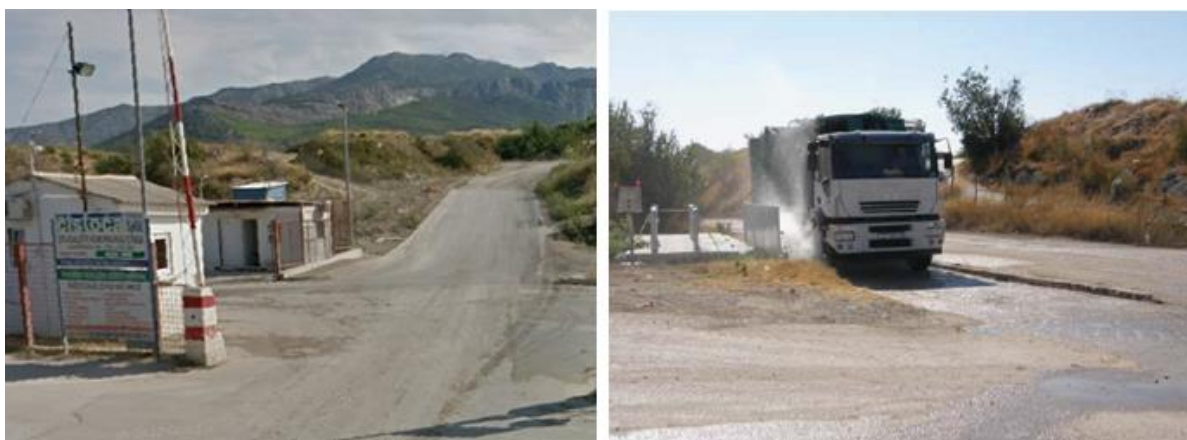
Slika 16. Ulaz na odlagalište otpada Karepovac (lijevo) i pranje kotača vozila (desno)
