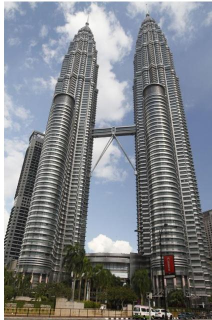
*Slika 1.1.: Petronas Twin Towers izgrađen od samozbijajućeg betona 1998. godine [3]*
