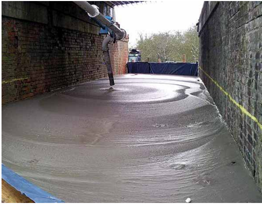
Slika 2.2 Pjenobeton [5]
