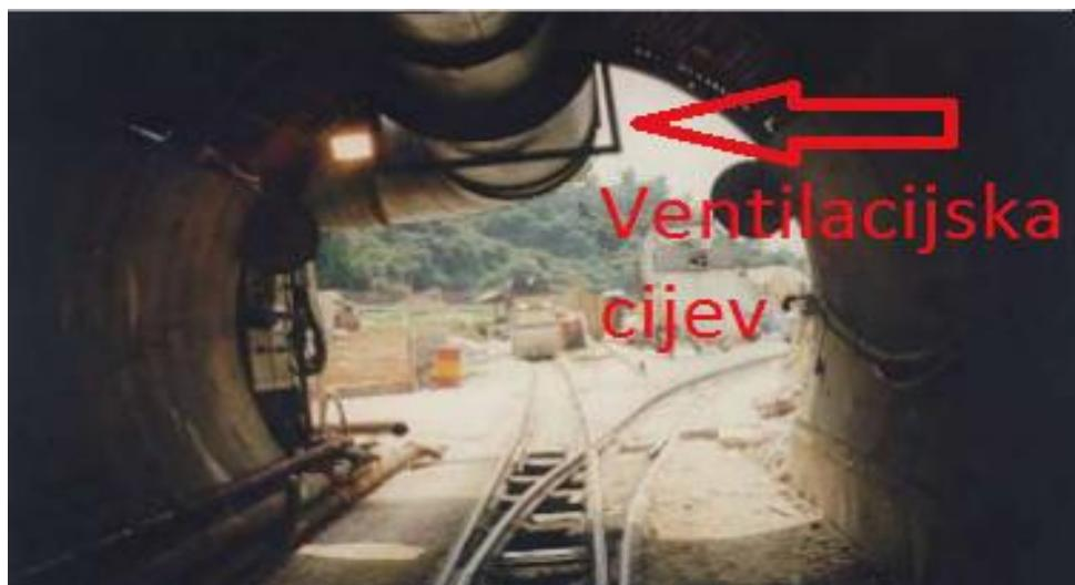
Slika 7-Prikaz ventilacijske cijevi u tunelu
