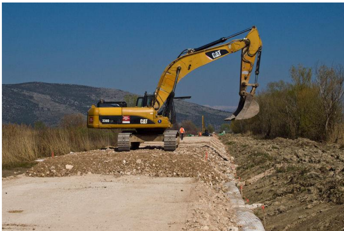
Slika 4.1.2.3. Gradnja nasipa za zaštitu od poplava na desnoj obali Neretve
