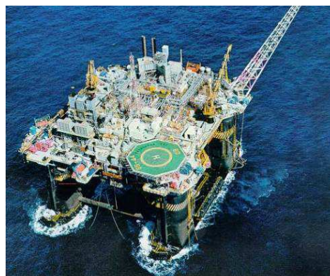
(d) offshore konstrukcije
