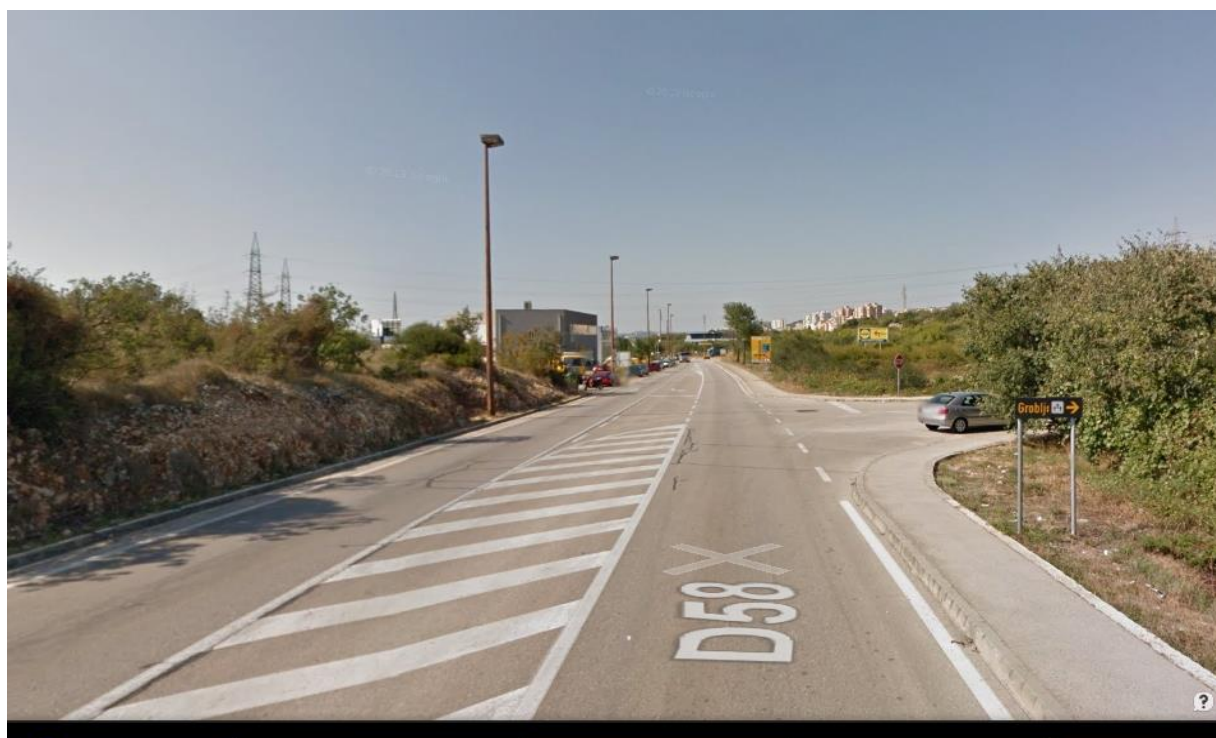
Slika 2. D-58 (Ulica Put Bioca), pogled prema zapadu
