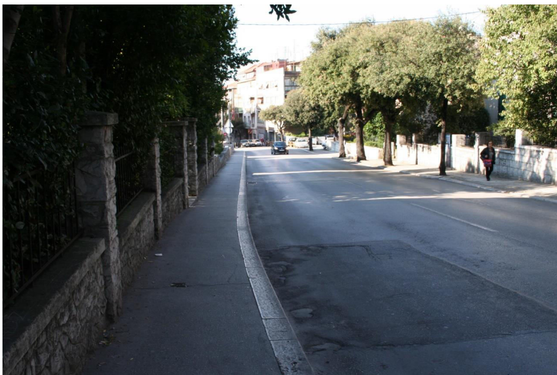
Slika 5 . Vukovarska Ulica (loše stanje kolnika)
