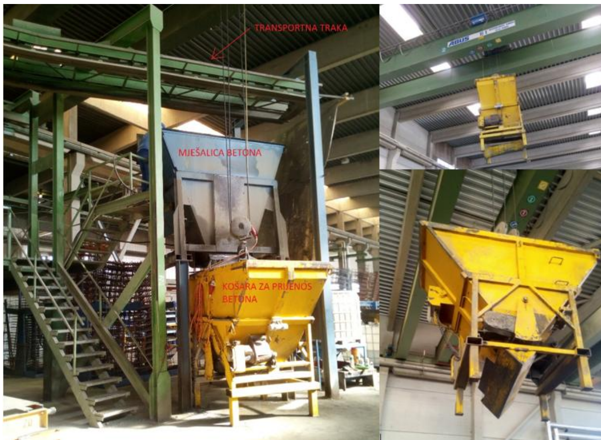
Slika 4.4 Priprema betonske mješavine te transport
