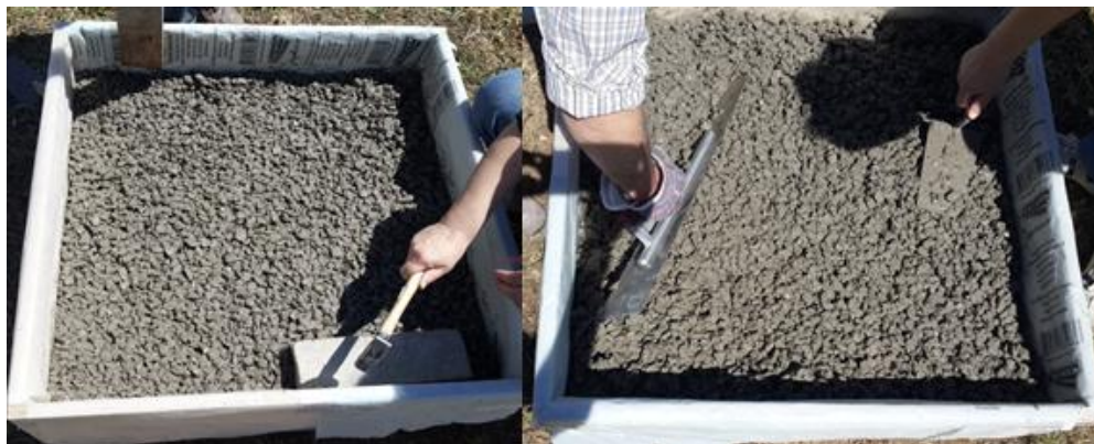
Slika 4.16 Proces ugradnje porozno – betonskih ploča [26]
