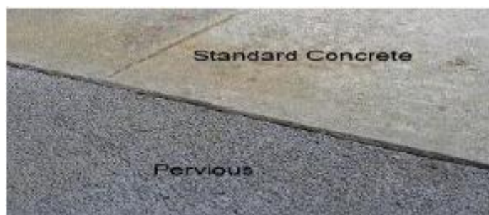
Slika 3.1 Usporedba poroznog i običnog betona [17]
