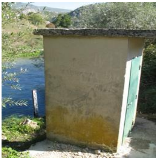
Slika 3.7. Hidrološka stanica Ruda1
