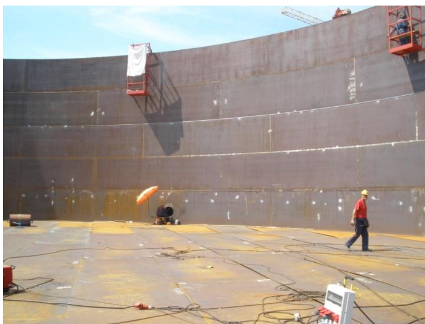
Slika 9. Plašt spremnika u izgradnji
