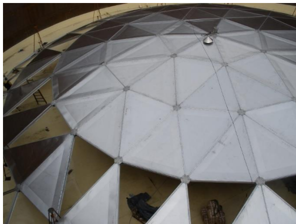
Slika 7. Aluminijska geodetska kupola u izgradnji
