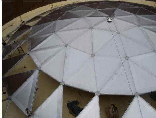
Slika 7. Aluminijska geodetska kupola u izgradnji
