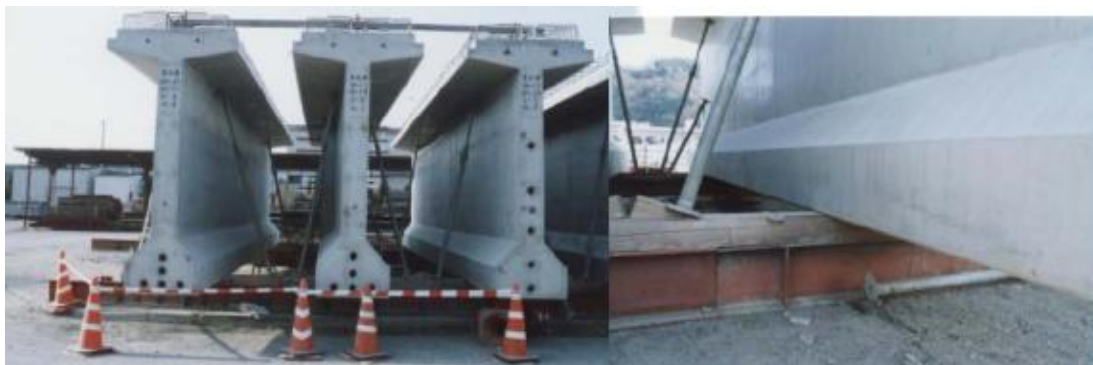
Slika 1.5.: Glavni nosači vijadukta Higashi-Oozu [12]
