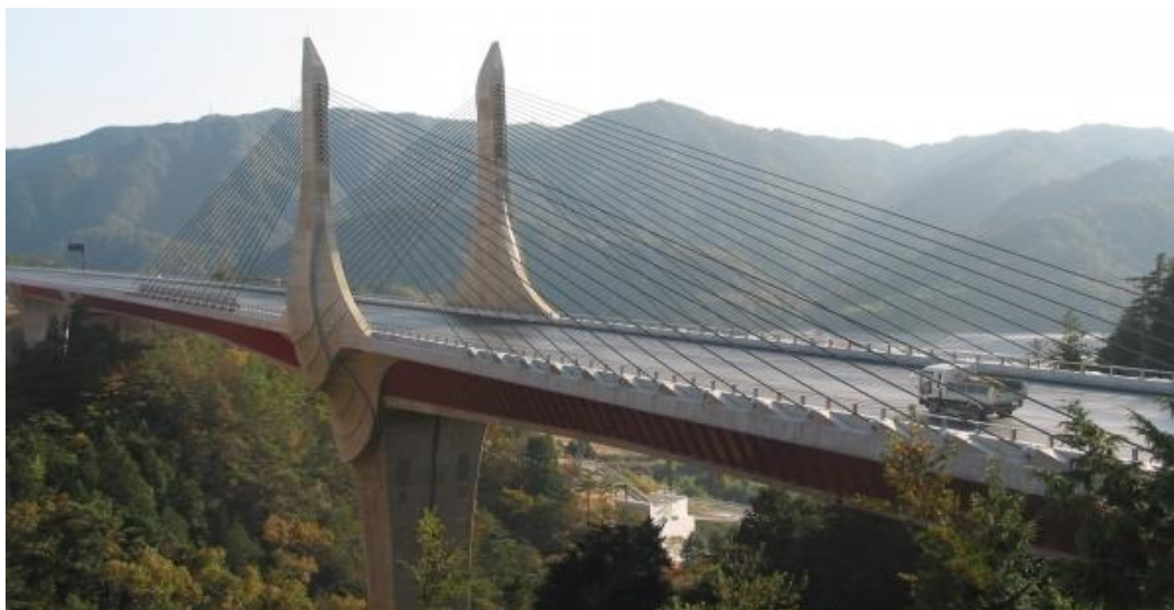
Slika 1.4.: Most Ritto Bridge [11]
