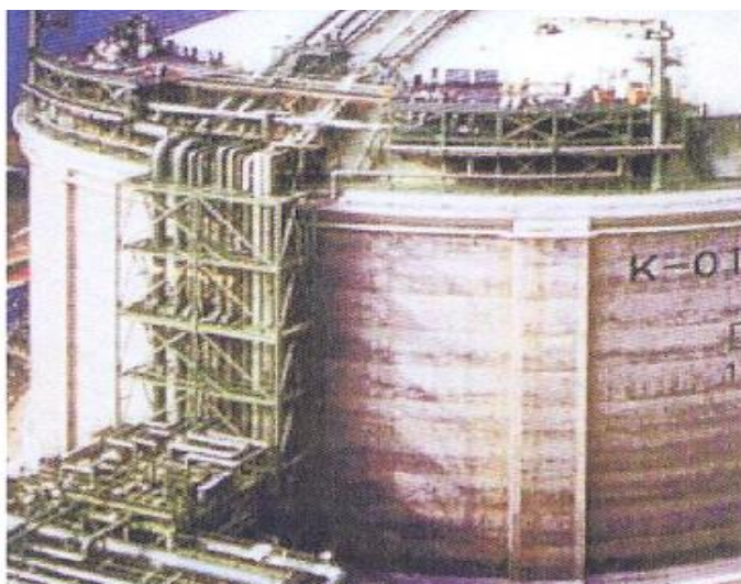
Slika 1.7.: Rezervoar LNG-a u Japanu [14]
