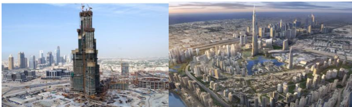
Slika 1.2.: Najviša zgrada na svijetu Burj Khalifa [9]
