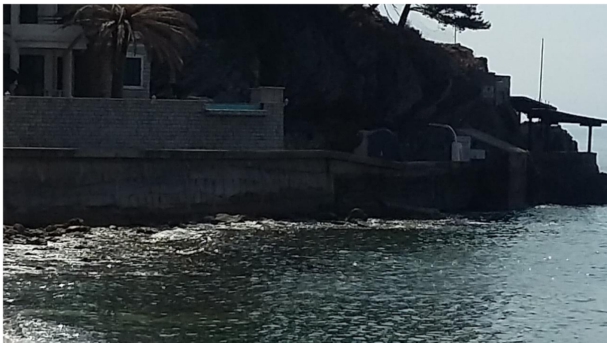
Slika 5.7 Detalj obalnog zida na istočnom rubu plaže Petrovac 25.03.2017.
