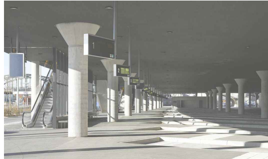
Central Bus Terminal_Auer+Weber+Assoziierte_Munich, Njemačka_2009
