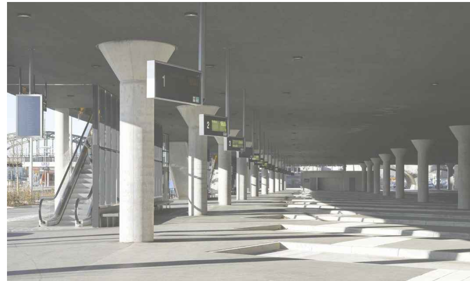
Central Bus Terminal_Auer+Weber+Assoziierte_Munich, Njemačka_2009
