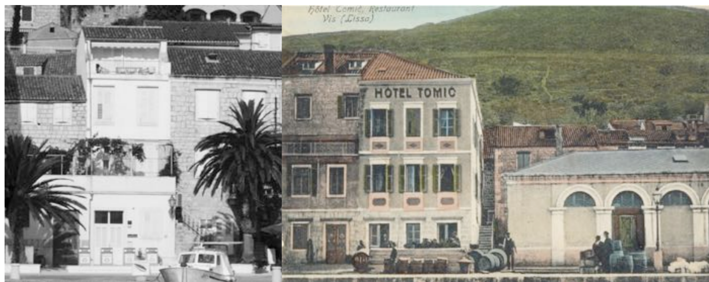
Fotografija 31. i 32.: Suvremeni apartmanski smještaj u Kutu i Austro-Ugarski hotel Tomić
