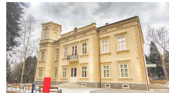
dvorac Bračak - nakon obnove
