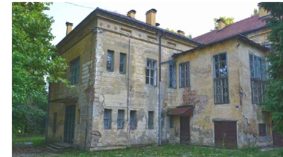
dvorac Bračak - prije obnove
