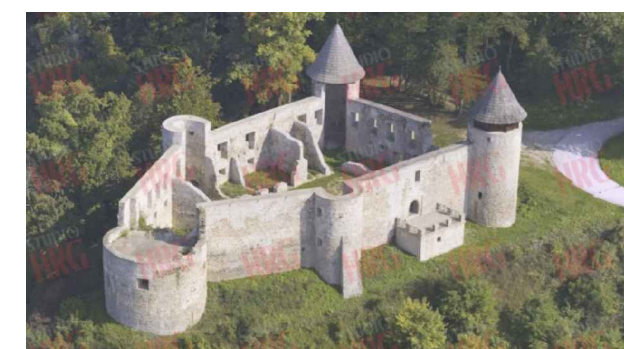
dvorac Frankopana u Novigradu na Dobri
