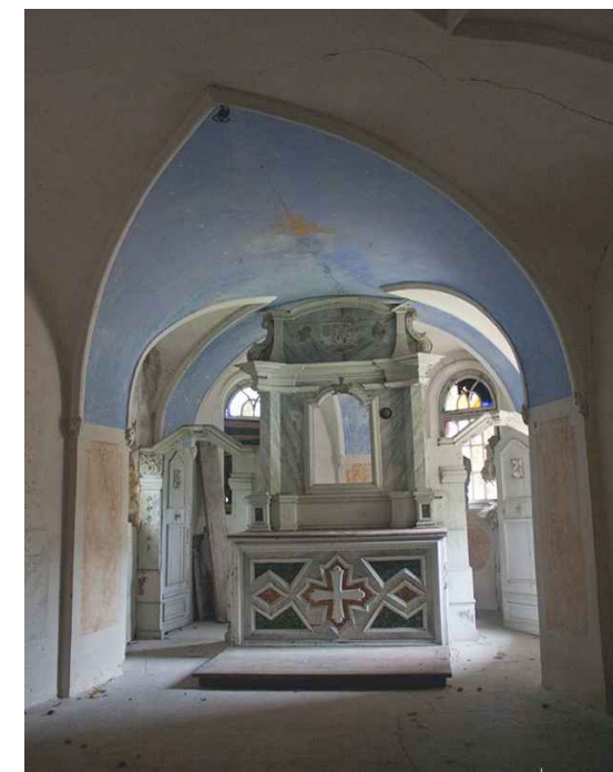
kapela prije restauracije
