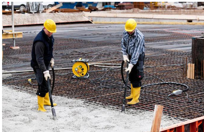
Slika 5.3. Korištenje vibro igle pri zbijanju betona [14]
