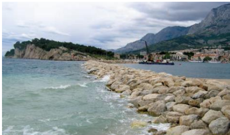
Slika 5.2. Izgled lukobrana nakon završetka postavljanja blokova [1]
