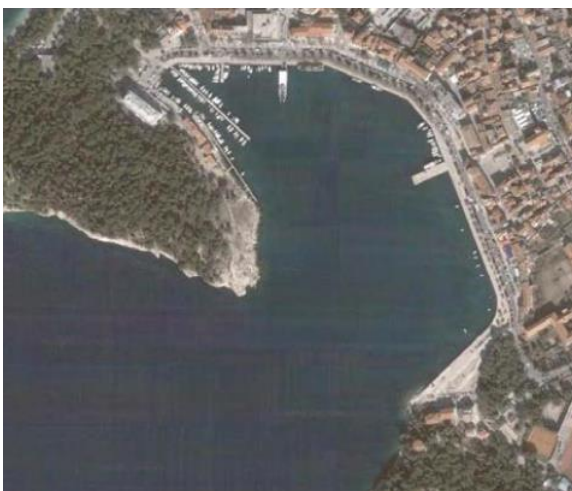
Slika 2.2.1 Stanje luke prije izgradnje [1]
