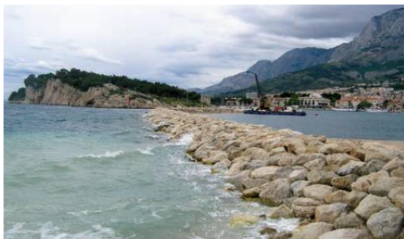
Slika 5.2. Izgled lukobrana nakon završetka postavljanja blokova [1]
