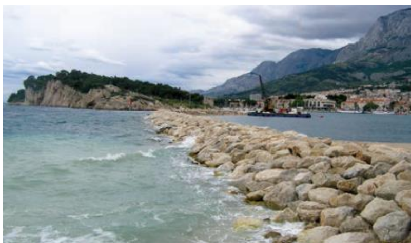
Slika 5.2. Izgled lukobrana nakon završetka postavljanja blokova [1]
