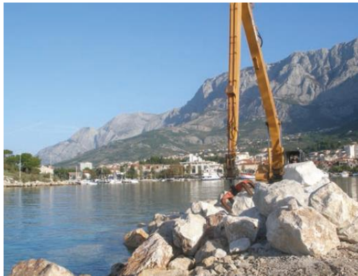
Slika 5.1. Postavljanje škojere pomoću plovne dizalice [1]
