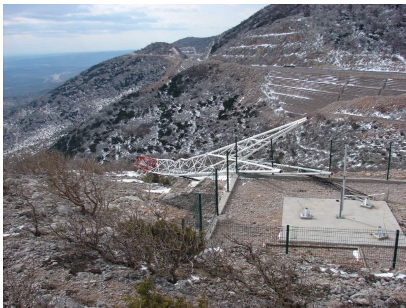
Slika 5.1 Srušeni antenski stup, Marune (južna padina Velebita, 2013)
