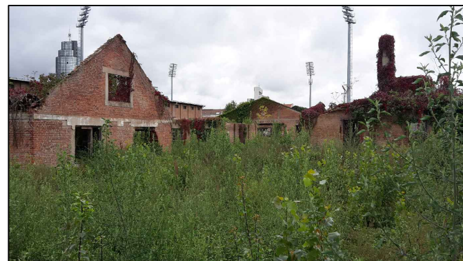
zatečeno stanje na parceli
