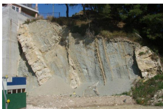
(e) 2010. (izrada zaštitne konstrukcije - II. faza)
