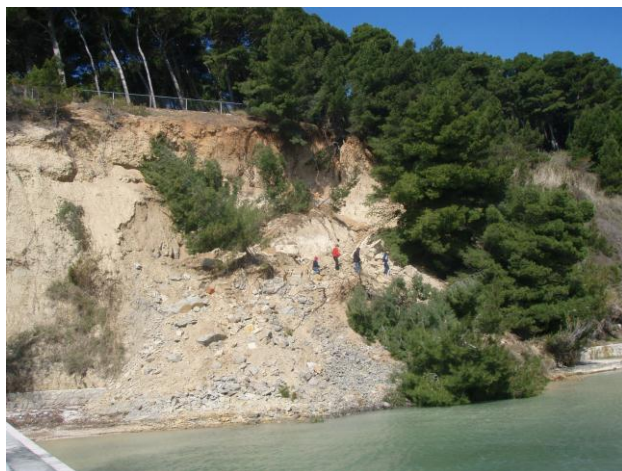
(a) Fotografija dan nakon klizanja (13.3.2010.)
