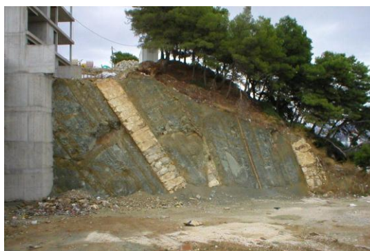
(b) 2004. (izrada zaštitne konstrukcije - I. faza)
