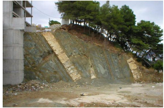
(b) 2004. (izrada zaštitne konstrukcije - I. faza)
