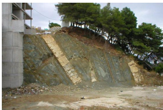
(b) 2004. (izrada zaštitne konstrukcije - I. faza)
