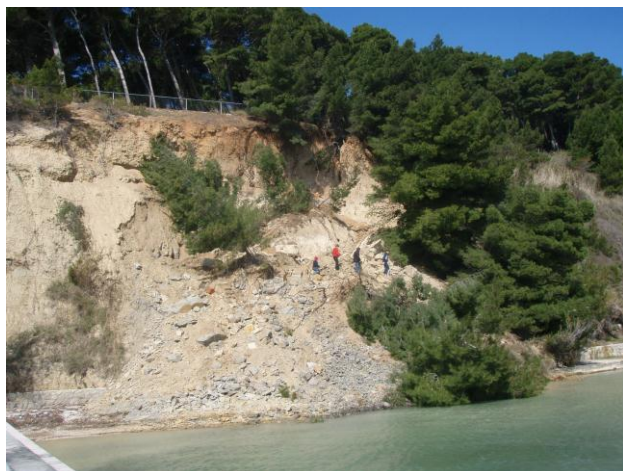
(a) Fotografija dan nakon klizanja (13.3.2010.)
