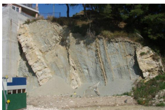
(e) 2010. (izrada zaštitne konstrukcije - II. faza)
