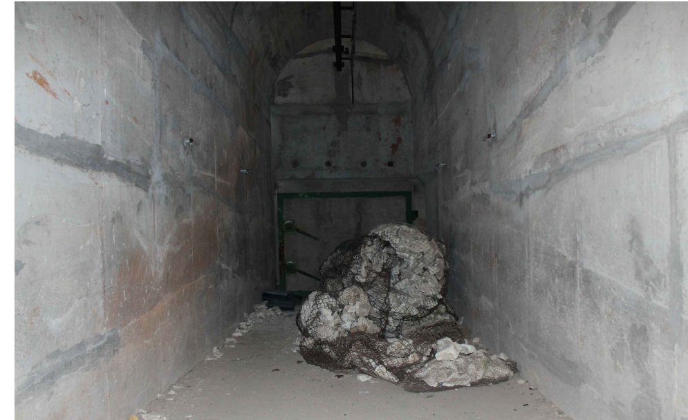
Prostorija unutar tunela
