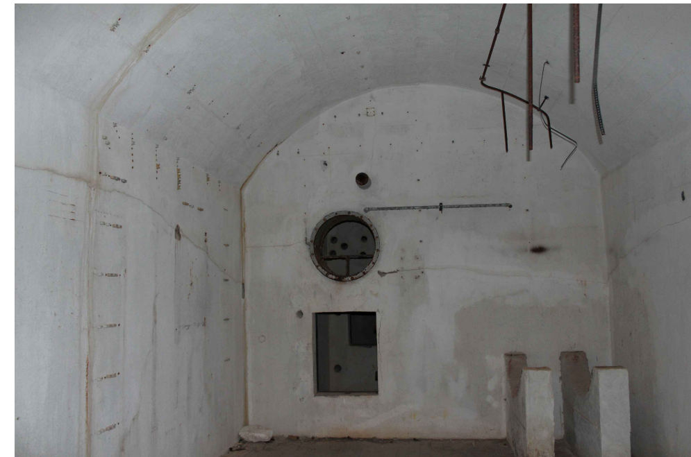
Prostorija unutar tunela
