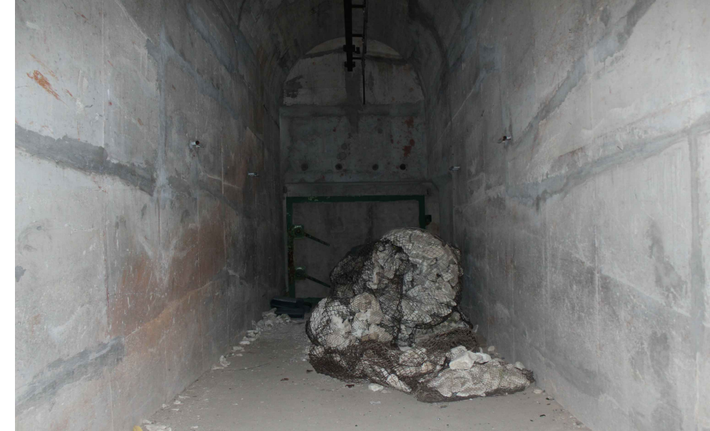
Prostorija unutar tunela
