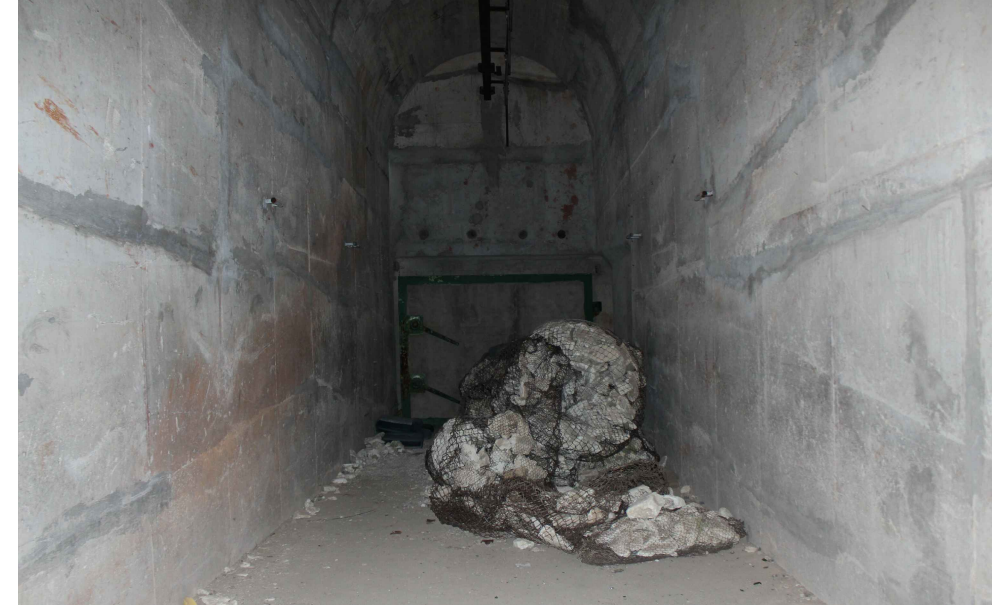
Prostorija unutar tunela
