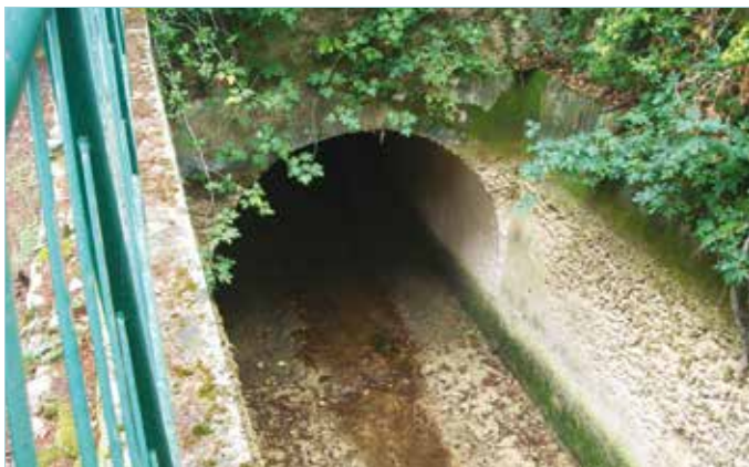
Slika 9: Dovodni tunel i kanal za HE Jaruga snimljeni 6. listopada 2015. U tom trenutku HE Jaruga nije radila (snimila: T. Roje-Bonacci)
